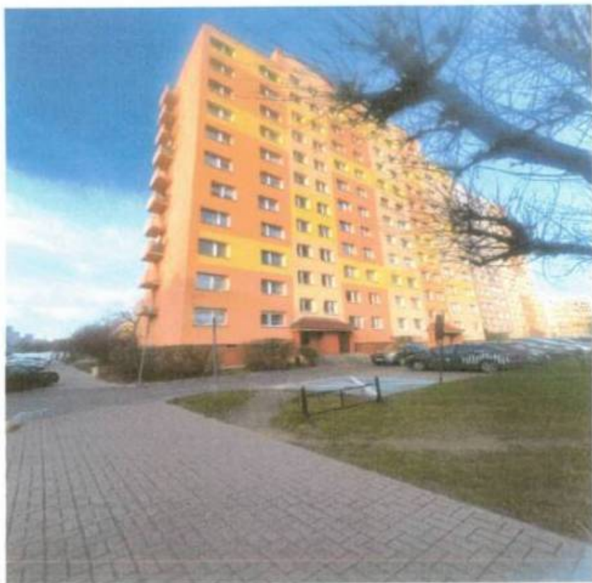
Fot. Budynek wielolokalowy ul. Wyspiańskiego 2 w Zgorzelcu..
