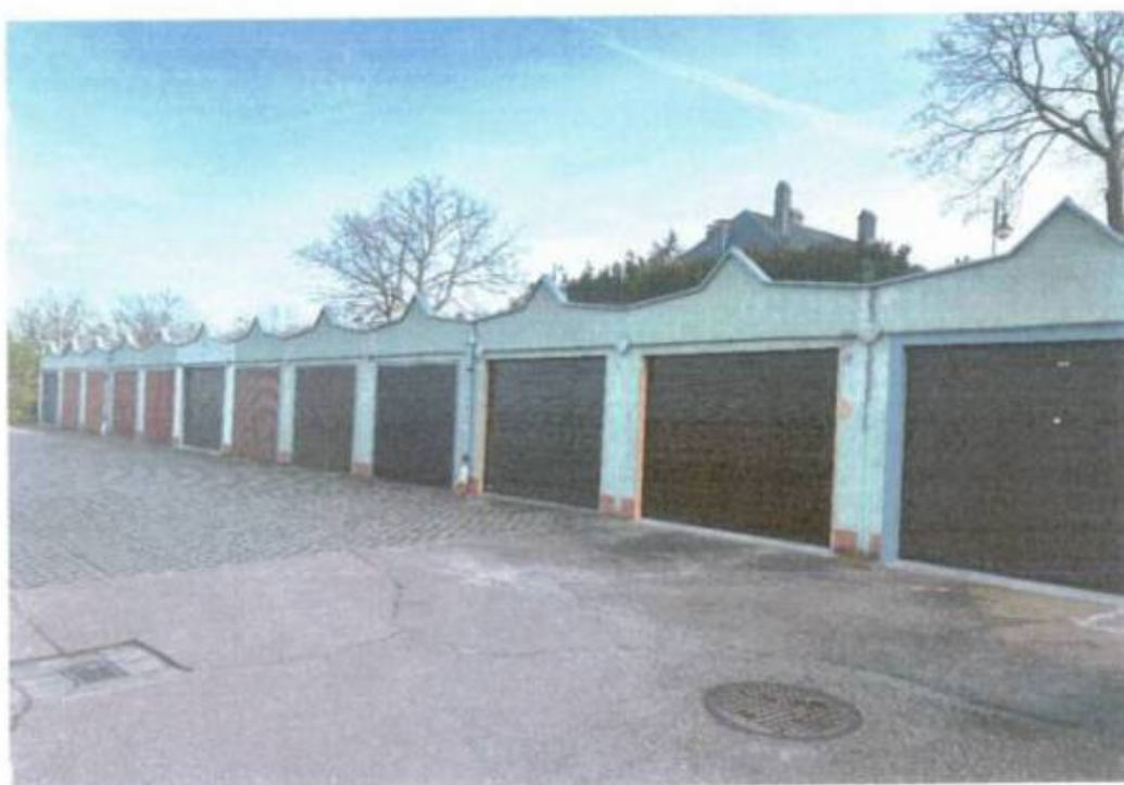
Fot. ciąg garaży nr 1 do 88 przy ul. Iwaskiewicza w Zgorzelcu
